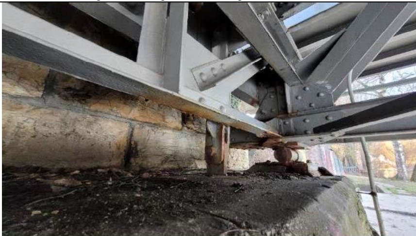
Bild 13: Widerlager und Zugband Flurlingen
