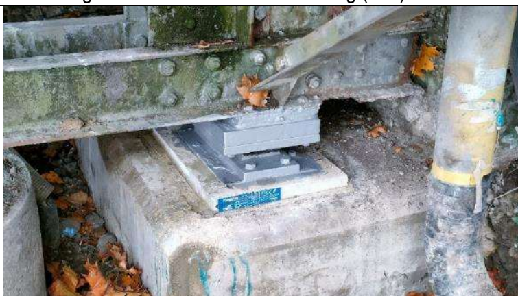
Bild 2: Lager Neuhausen oberwasserseitig (neu)
