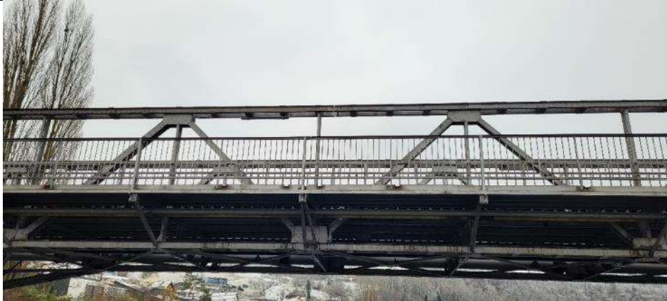
Bild 4: Fussgängersteg von Aussen
