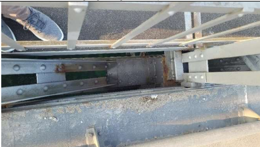
Bild 6: Zwischen Fussgängersteg und Hauptbrücke
