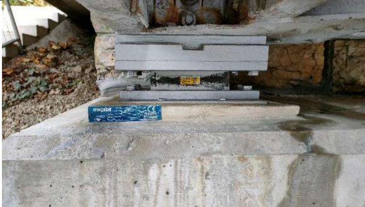
Bild 4: Lager Flurlingen oberwasserseitig (neu)
