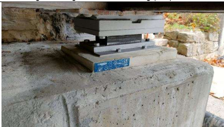
Bild 3: Lager Flurlingen unterwasserseitig (neu)
