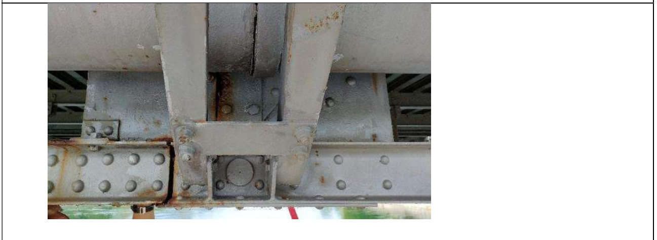
Bild 2: Ansicht von aussen, Abdeckung entfernt (starke Korrosion)
