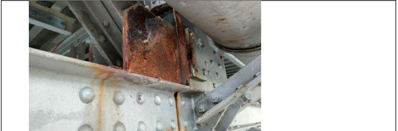
Bild 2: Ansicht von aussen, Abdeckung entfernt (starke Korrosion)
