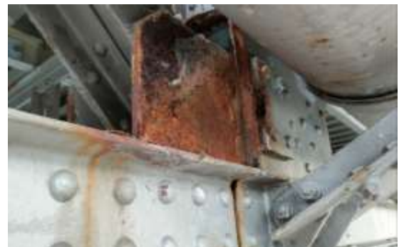
Abb: 3 Gelenkknote, Seite Flurlingen unterwasserseitig
